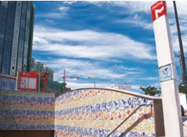
Estação de Metro das Oaias _ Lisboa, Portugal Oaias Underground Station _ Lisbon, Portugal
