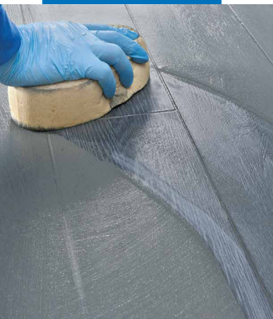
Limpeza e acabamento das juntas com esponja de celulose dura
