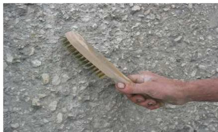
Remoção das matérias desagregadas
