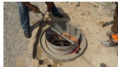
Enchimento do molde.
