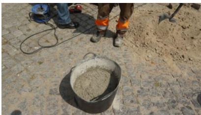
Amassadura do BETÃO-S ESTRUTURAL RÁPIDO NEGRO .
