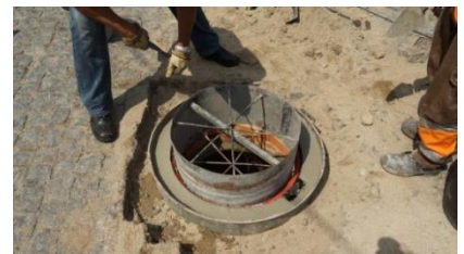
Enchimento do molde.
