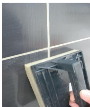
Limpeza do excesso de argamassa
