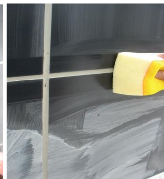
Limpeza do excesso de argamassa
