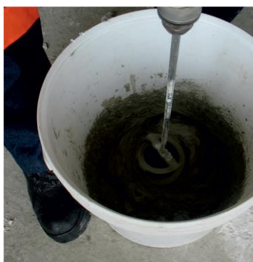
Amassadura do ADHERE COR 05
