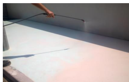
5. Aplicação do desativante de superfície SCALA AD 31 ou SCALA AD 32 para acabamento desativado
