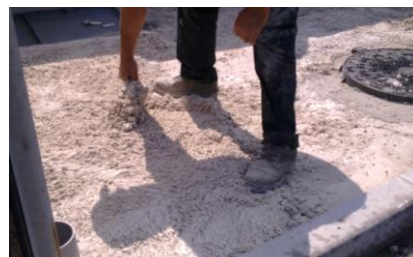
3. Colocação da argamassa SCALA DECOR
