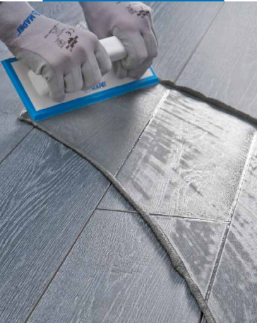
Aplicação de Ultracolor Plus em pavimento com espátula de borracha sobre ladrilhos em grés porcelânico efeito madeira
