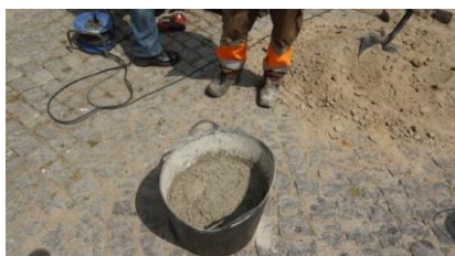
Amassadura do BETÃO-S ESTRUTURAL RÁPIDO
