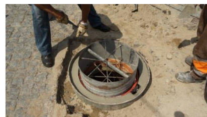
Enchimento do molde com BETÃO-S ESTRUTURAL RÁPIDO
