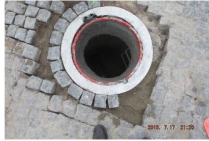
Nivelamento com o pavimento
