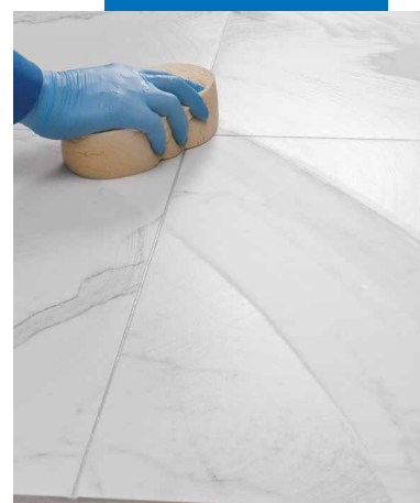
Limpeza e acabamento das juntas com esponja de celulose dura
