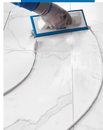
Aplicação de Ultracolor Plus em pavimento com espátula de borracha em ladrilhos de grés porcelânico feito mármore
