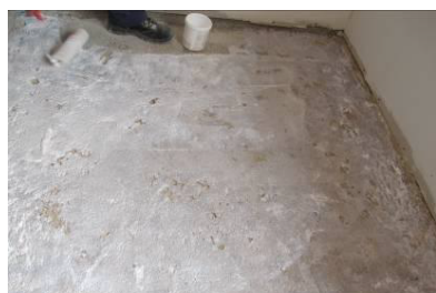
Aplicação do primário MICROART AD 21
