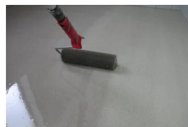
Uniformização da superfície c/ rolo de bicos
