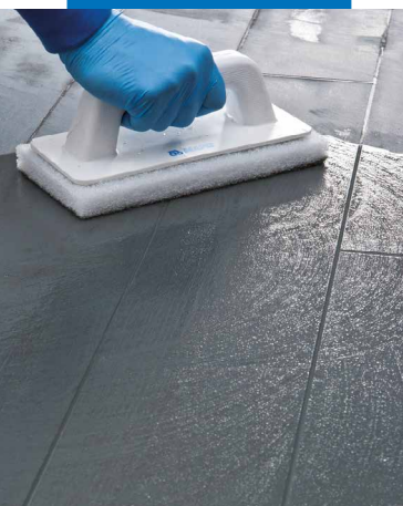
Limpeza das juntas com Scotch-Brite® pad (com o produto parcialmente endurecido)
